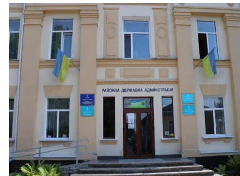
приміщення Ніжинської РДА
